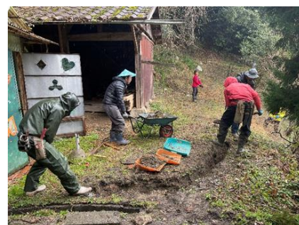
▲ 排水をどこにするか検討しながら作業進行
